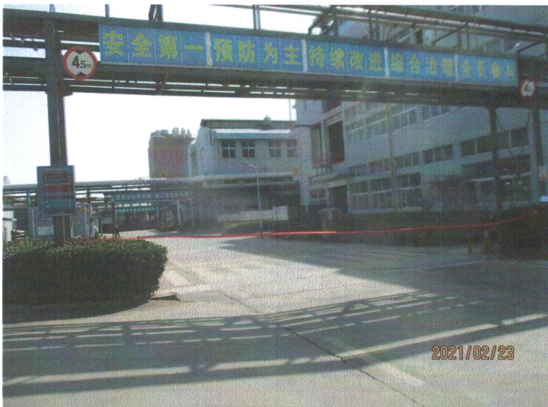
15、安全隔离人员徐建明、唐捷对事故现场安全隔离
